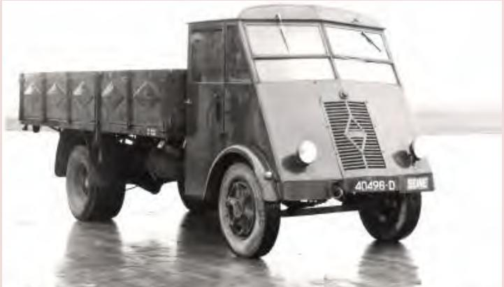
CAMION RENAULT AHN 2 - 1946 - MOTEUR 6 CYLINDRES - ESSENCE - SERVO-FREIN RECHARGEABLE À TRANSMISSION HYDRAULIQUE - C.U. 3,5 T.
